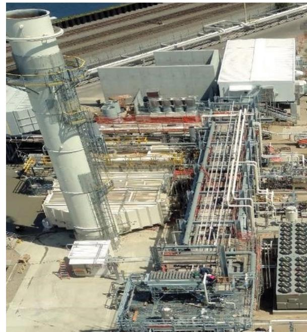
La nouvelle centrale de cogénération de la raffinerie de Wilmington produit efficacement de l'électricité ainsi que de la vapeur qui est recyclée dans le processus de raffinage.
