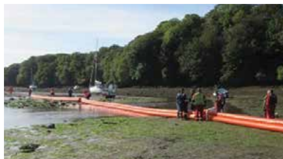
▲ La raffinerie Valero de Pembroke participe à une simulation de déversement où l'on déploie des estacades pour protéger un marais salé extrêmement fragile sur le plan écologique. Les estacades sont ancrées et reliées par des chaînes pour diriger le pétrole vers une zone où il peut être récupéré.
